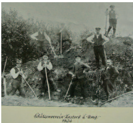
Die Vereinsgründer im Jahr 1924 beim Bau des Schießstandes am Müssenkamp. Weder Bagger noch Raupe standen zur Verfügung. Die Arbeit musste mit Hacke, Schaufel und Spaten gemacht werden.
