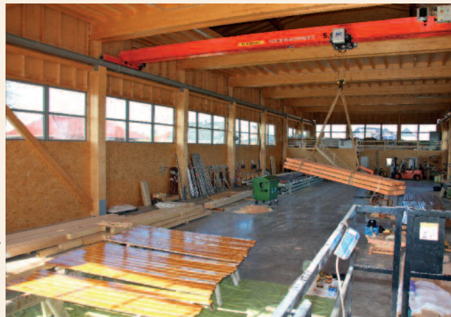
Die neue Halle hat eine Nutzfläche von 1.600 Quadratmetern auf drei Etagen, einen 5-Tonnen-Deckenkran und Montagetisch.
