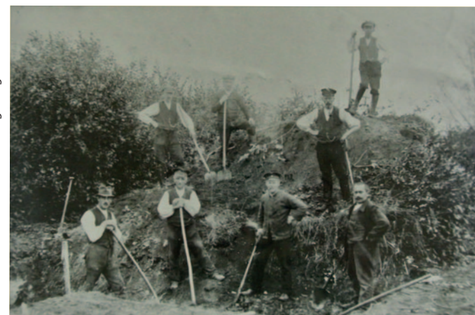
Mit vereinten Kräften bauen die Kastorfer Schützen ihren Schießstand und das erste Schützenheim. Fertigstellung: September 1925.
